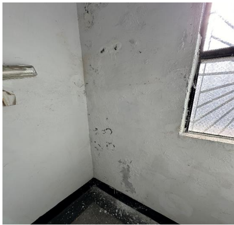
2樓房間(壁癌及粉刷、塑膠地板重整)
